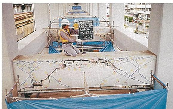
梁上下平面及び垂直面へのIPHカプセル注入状況
