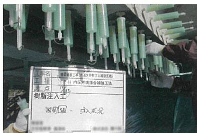
4 注入硬化養生 (IPHカプセル)
