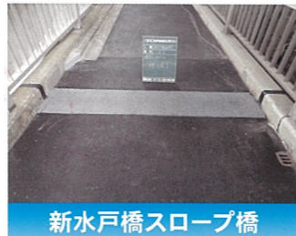
新水戸橋スロープ橋
